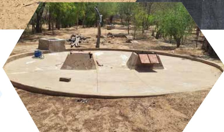
*Eine Anlage zum Auffangen des Regenwassers*
